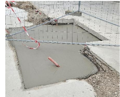
Fondation de l'exostructure
