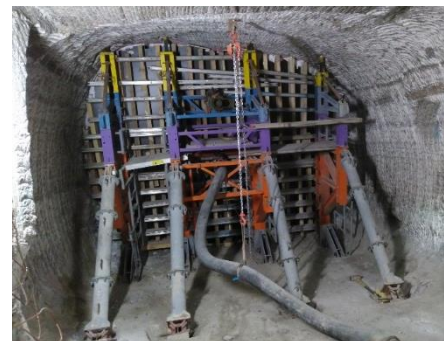
Coffrage final + injection BAP
